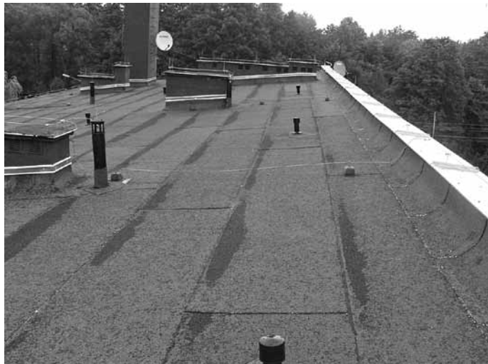
Widok połaci dachowej po wykonaniu ułożenia papy termozgrzewalnej fot. Robert Gładys
