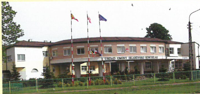
Budynek Urzędu Gminy
