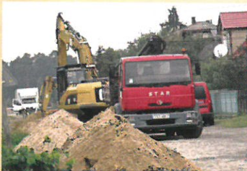
Budowa kanalizacji w Majkowie
