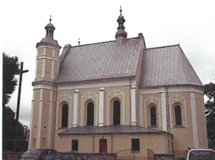
Odnowiona elewacja i dach kościoła parafialnego
