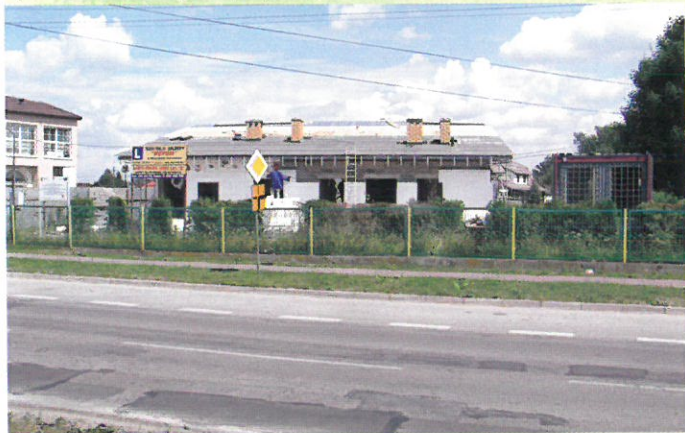
Aktualne prace związane z ociepleniem zaplecza sceny i wykonaniem poszycia dachu
