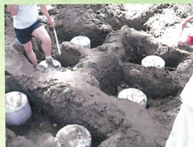
Montaż stóp fundamentowych pod urządzenia wyposażenia placu zabaw przedszkola – lipiec 2010
