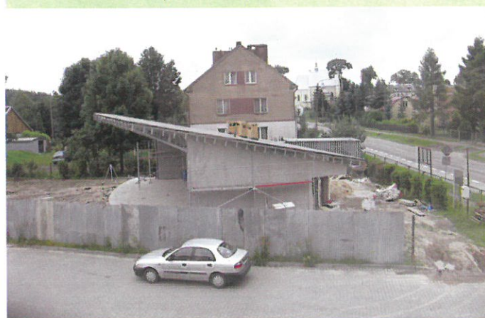
Dach sceny i punktu informacji turystycznej z wykonanymi kominami – lipiec 2010
