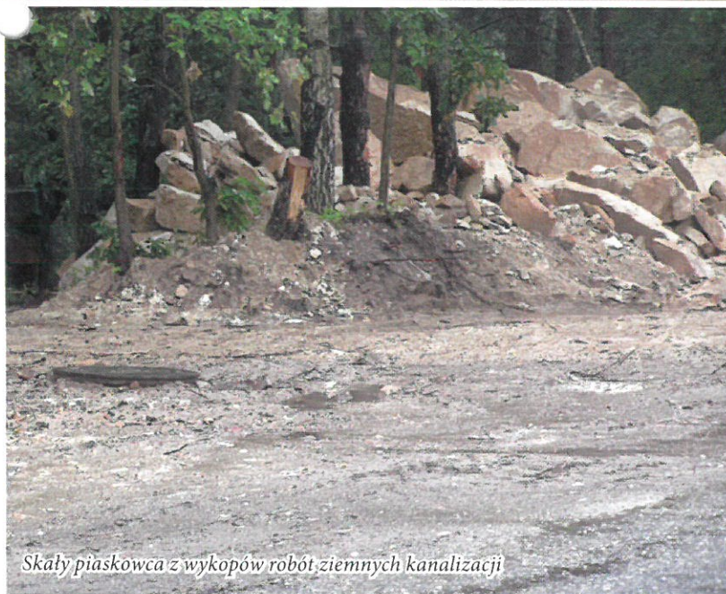
Majków, ul. Żeromskiego, teren po ułożeniu odcinka kanału tłoczego
