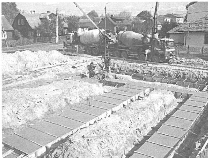
Betonowanie ław fundamentowych fot. R.Gładys
