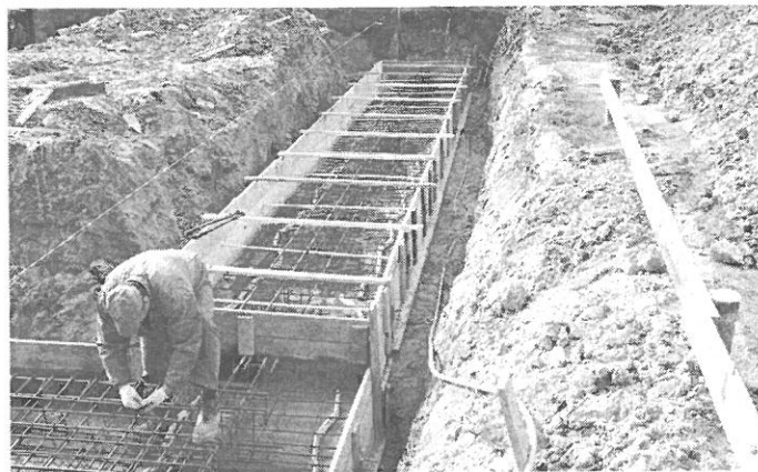
Zbrojenie ław fundamentowych fot. R.Gładys
