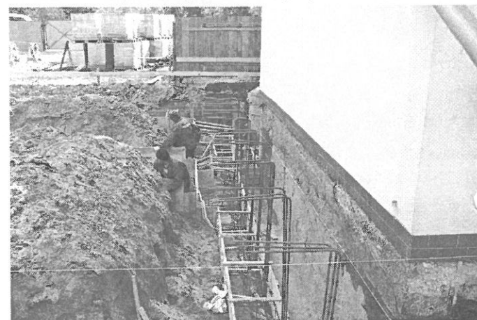
Zbrojenie ław fundamentowych przy dylatacji fot. R.Gładys
