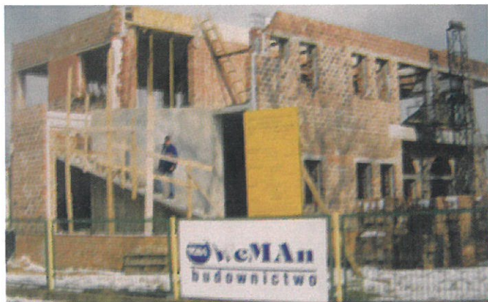
Budowa UG postępuje szybko
