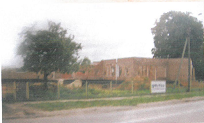
Rozpoczęcie budowy siedziby Urzędu Gminy
