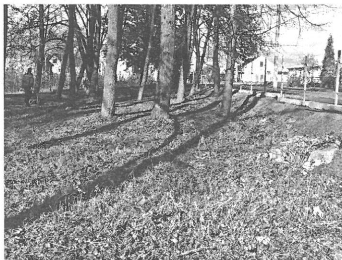
Teren pomiędzy drzewami w trakcie prac porządkowo-przygotawczych
