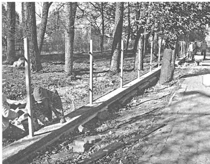
Na wykonanych murkach ogrodzenia rozpoczęto układanie płytek klinkierowych
