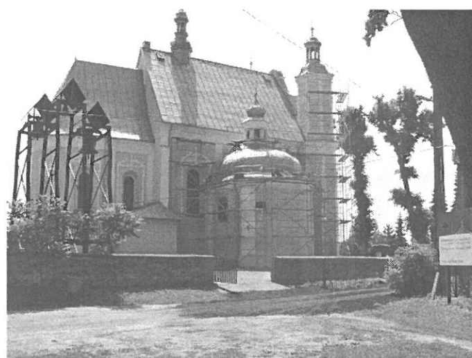
Kaplica Aniołów Stróżów w trakcie prac renowacyjnych
