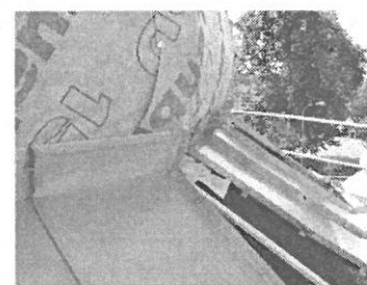
Układ blach na kopule kaplicy
