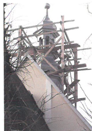
Konstrukcja drewniana rusztowań sygnatury
