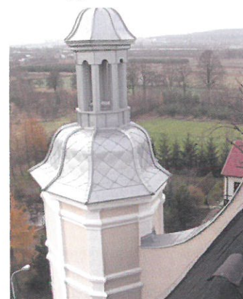
Widok z kalenicy na odnowioną wieżę południową kościoła
