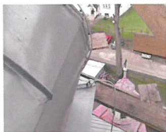
Trwa wykonywanie robót blacharskich i obróbek na kopulce sygnatury.
