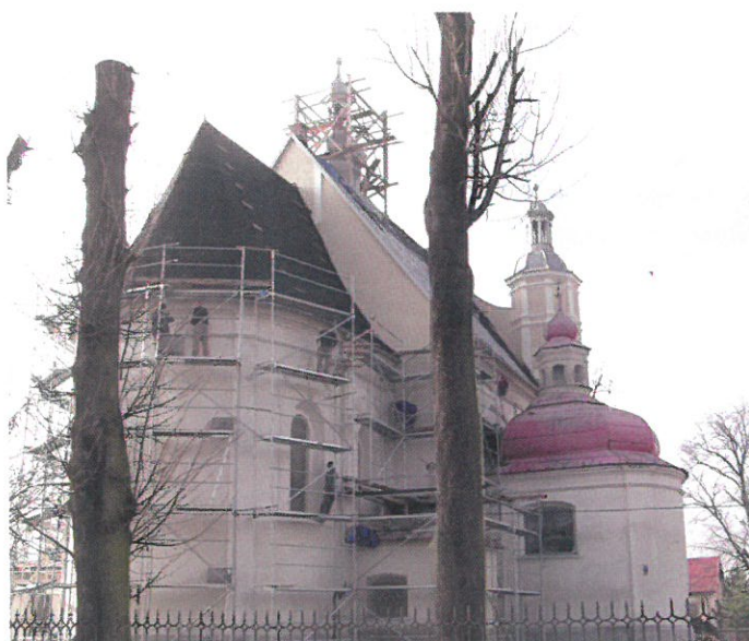
Naprawa detalu architektonicznego elewacji prezbiterium
