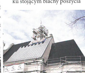
Na ponad połowie nawy głównej została już ułożona blacha tytanowo-cynkowa
