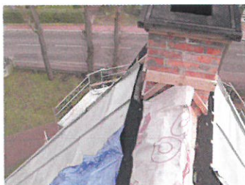
Komin spalinowy w kalenicy dachu został całkowicie odbudowany.
