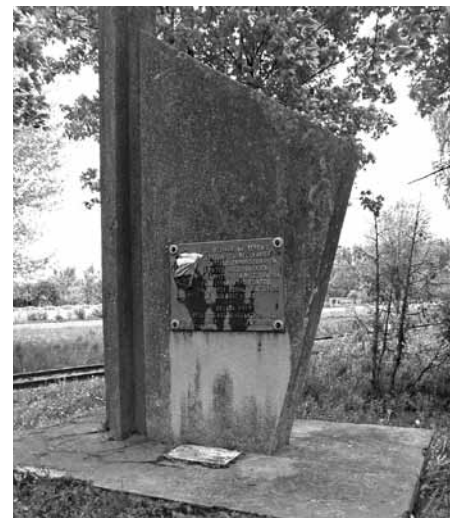
Pomnik wymaga remontu
