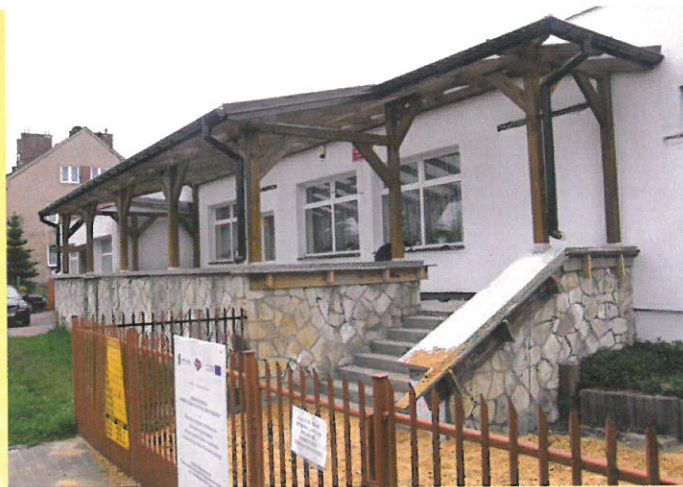
Wybudowane zadaszenie tarasu
