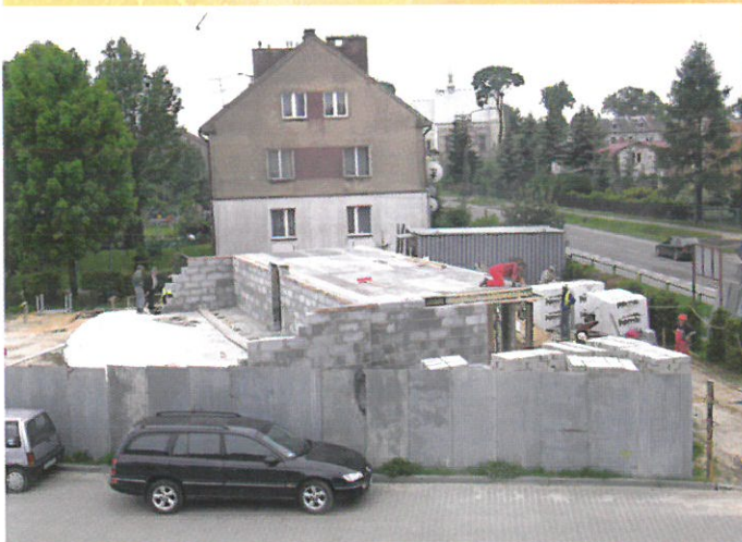
Budowa sceny koncertowej i punktu informacji turystycznej
