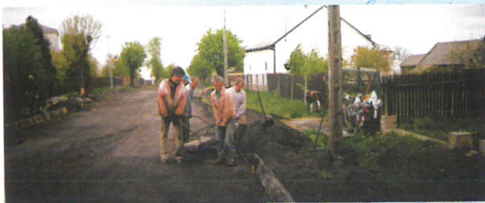
Budowa drogi w Lipowym Polu
