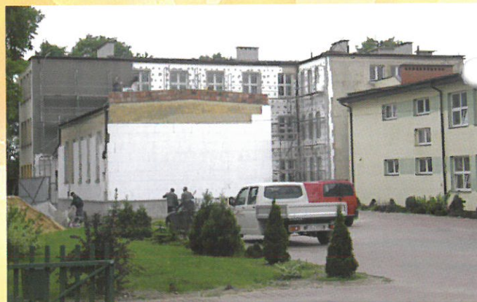
Prace przy ociepleniu budynku szkoły
