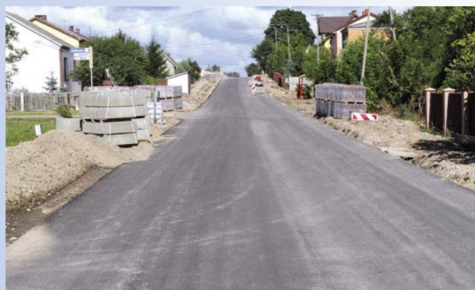
Budowa drogi w Kierzu Niedźwiedzim
